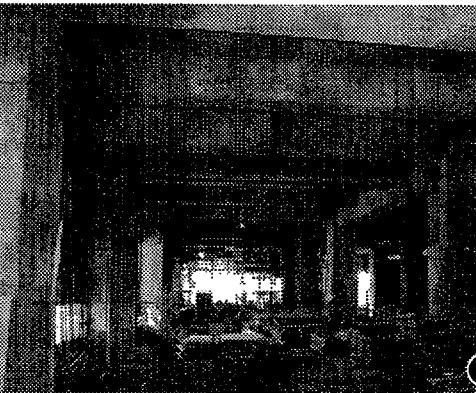
写真③は、3階の病棟付近の写真です。まだ床にはコンクリートが打たれておらず鉄筋の配筋状況がわかります。屋根がかかっていませんが、これは雪対策用の仮設の屋根で、工事が上階に進むに連
