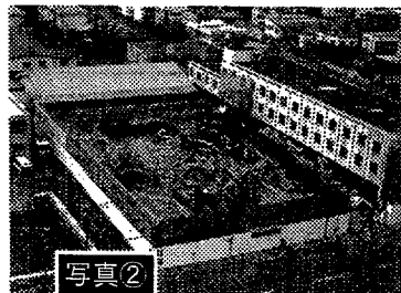
写真2 駐車場の解体 H20.11
